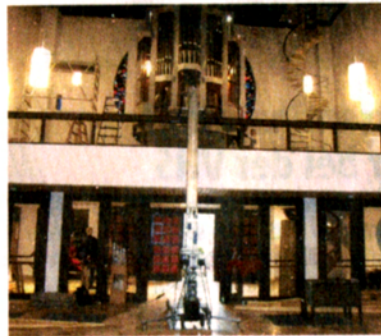
Der Kran für die Demontage. FOTO: PRIVAT
